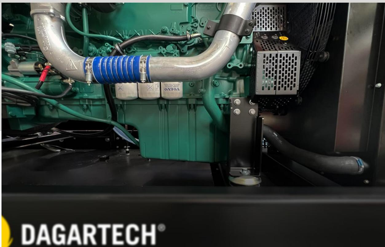
La utilización de diversos sistemas antivibratorios en grupos electrógenos es imprescindible para combatir los efectos de las vibraciones derivadas de su funcionamiento.
